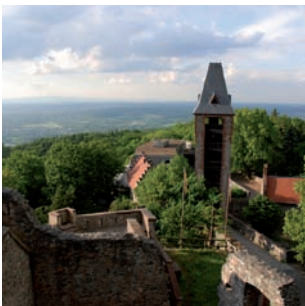
Blick von der Kernburg nach Norden
